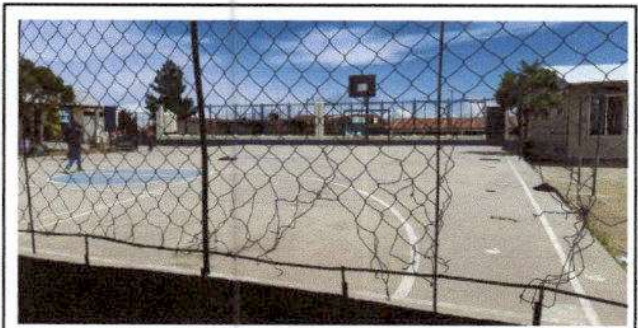
Foto 4: Reparación de malla galvanizada.
