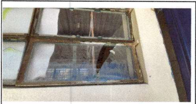
Foto 2: Sustitución de los vidrios de aulas del establecimiento.
