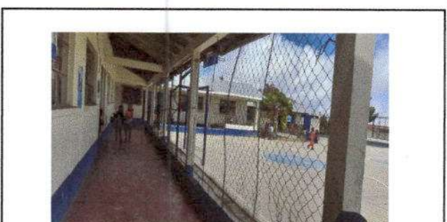
Foto 6: Reparación de malla galvanizada.
