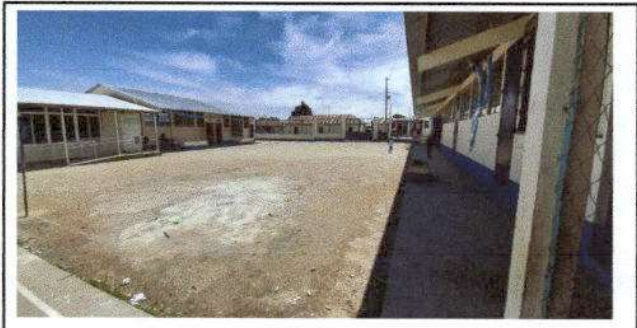
Foto No. 3: Sustitución de piso torta de concreto.
